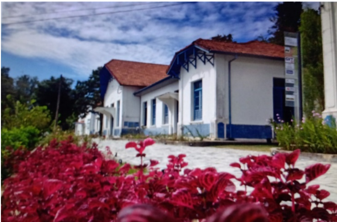
Figura 4 – Outro pavilhão da fábrica com arquitetura restaurada e sede da Bituca Universidade de Música formada pela comunidade de Barbacena, MG. Foto: Gabriel Castro, 2015.
