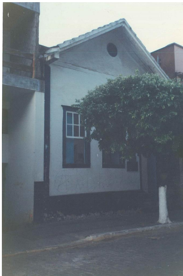
Imagem 1 Fachada do “Espaço dos Anjos”
