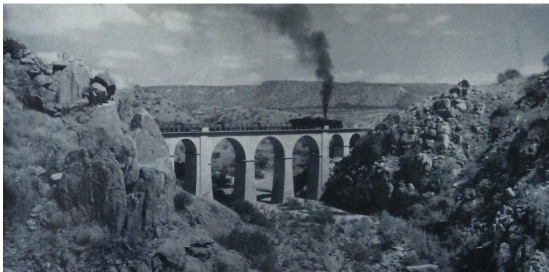
Figura 10 – Locomotiva sobre a ponte Comandante Álvaro Machado no desfiladeiro do Lengue na linha de Benguela (década de 1930)
