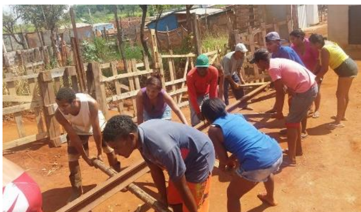
Imagem 8 – Construção de ponte pela população da Cidade Locomotiva (Ribeirão Preto/SP)
