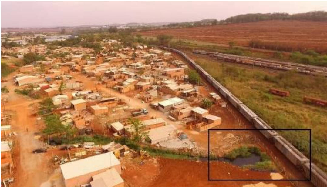
Imagem 3 – Esgoto a céu aberto e a Ferrovia Centro-Atlântica na Cidade Locomotiva (Ribeirão Preto/SP)
