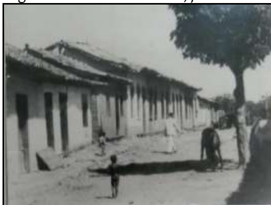
Figura 8 - Casarios em Crixás, já demolidos
