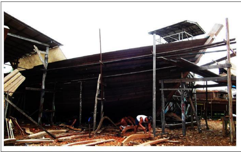
Figura 2 - Construção de embarcação em estaleiro em Abaetetuba Foto: Madson Quaresma, 2013.
