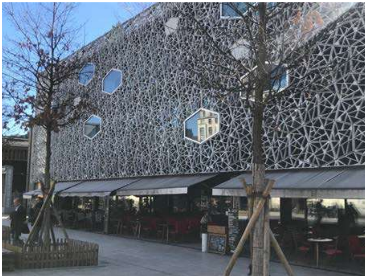
Fig. 9: Burckhardt + Partner SA: Les Pépinières (2014), Esplanade du Flon, Côtes-de-Montbenon 20, Lausanne.
