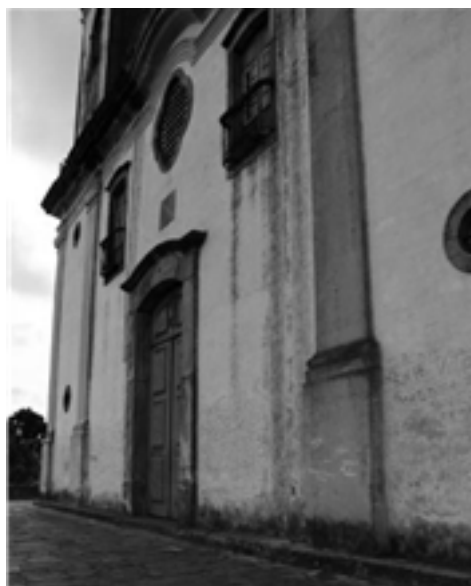
Figura 1: fachada da Igreja
