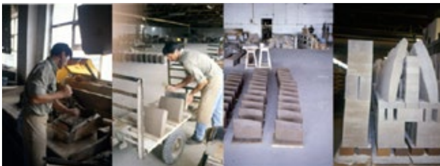
Fig. 6: O monumento à vida foi concebido como uma obra de caráter industrial. Por outras palavras, a construção da escultura esteve intimamente ligada aos modos de produção ancestral da Abrigada: moldagem manual, cofragem de madeira, e a seriação de peças de grés.
