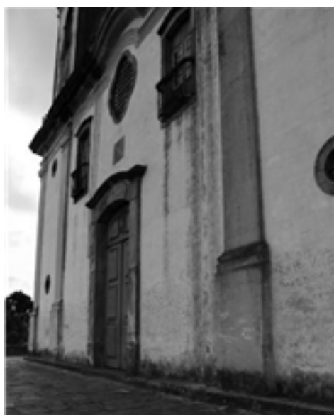
Figura 1: fachada da Igreja
