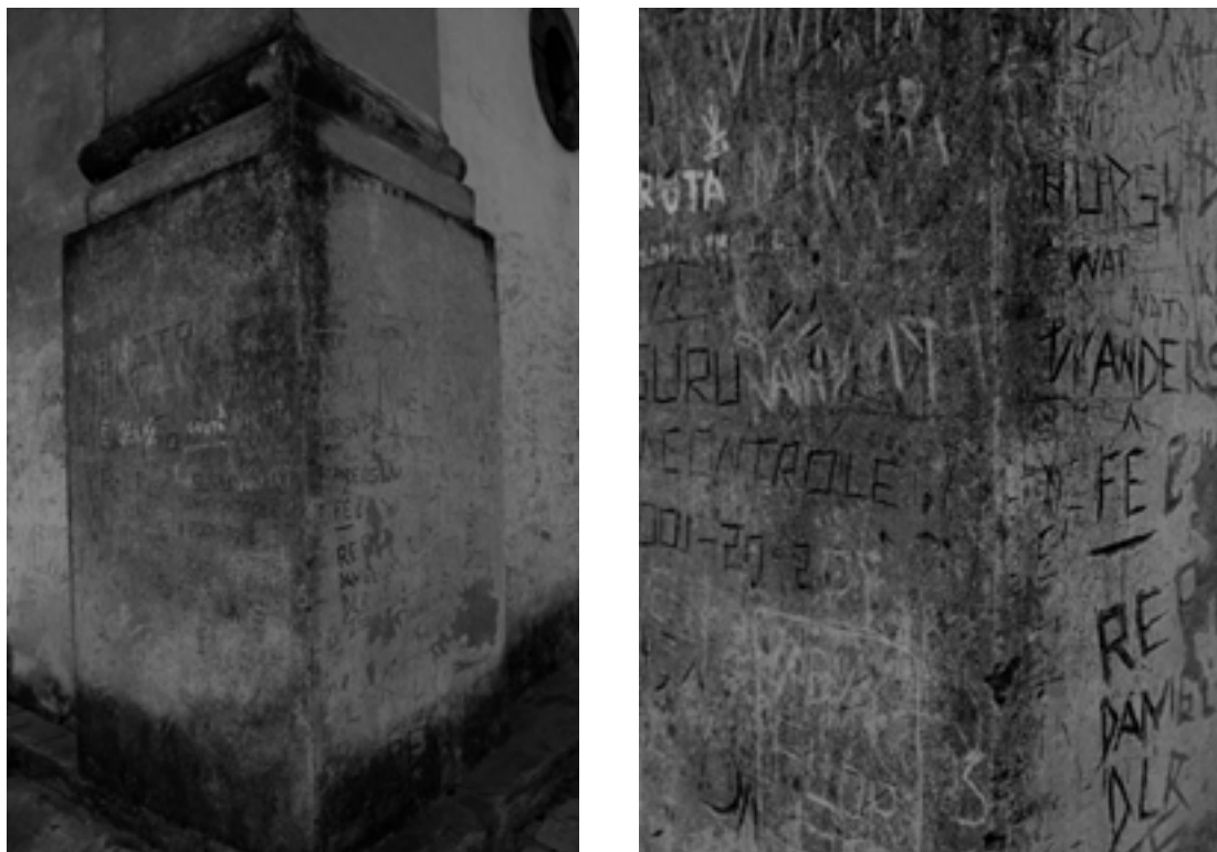
Figura 2 e 3: detalhes da fachada
