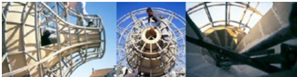
Fig. 7: O corpo de ferro, além de determinar o volume da forma escultural, foi concebido como uma estrutura de suporte primário para os módulos de grés, que, uma vez montados dentro dele, permitiram uma simbiose estética entre materiais e a afirmação de uma geometria elementar própria dos elementos naturais.
