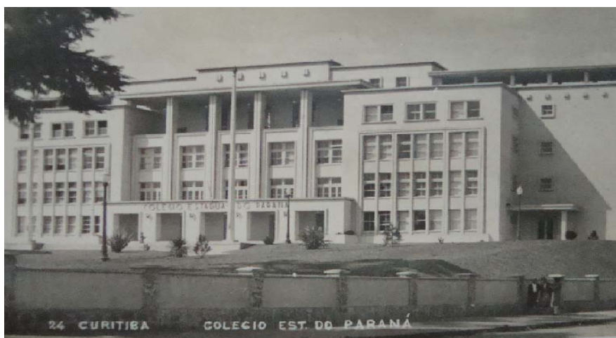
FIGURA 01 – FACHADA DO PRÉDIO PRINCIPAL
