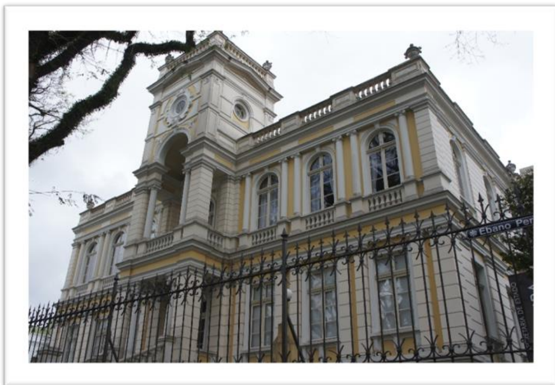
Figura 2: Edifício da Secretaria de Estado da Cultura do Paraná, 2013
