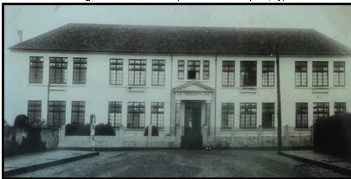
Figura 2 – Prédio do Grupo Escolar Farroupilha, 1938
