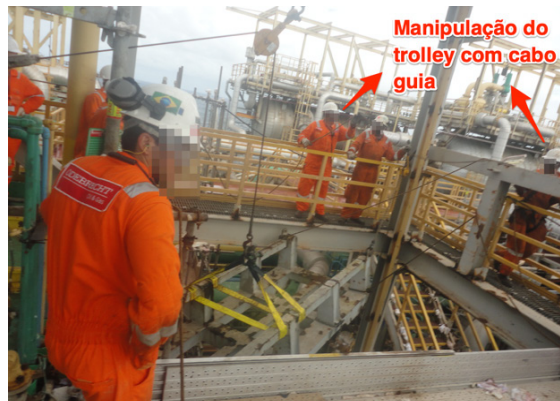
Figura 9 – Manipulação do trolley com cabo guia (Caso B)
