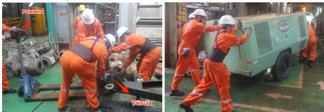
Figura 6 – Remoção de equipamentos do piso do corredor vertical (Caso B)
