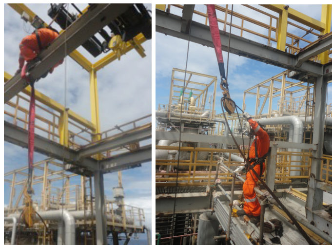
Figura 5 – Montagem das roldanas e passagem dos cabos dos tirfores (Caso B)
