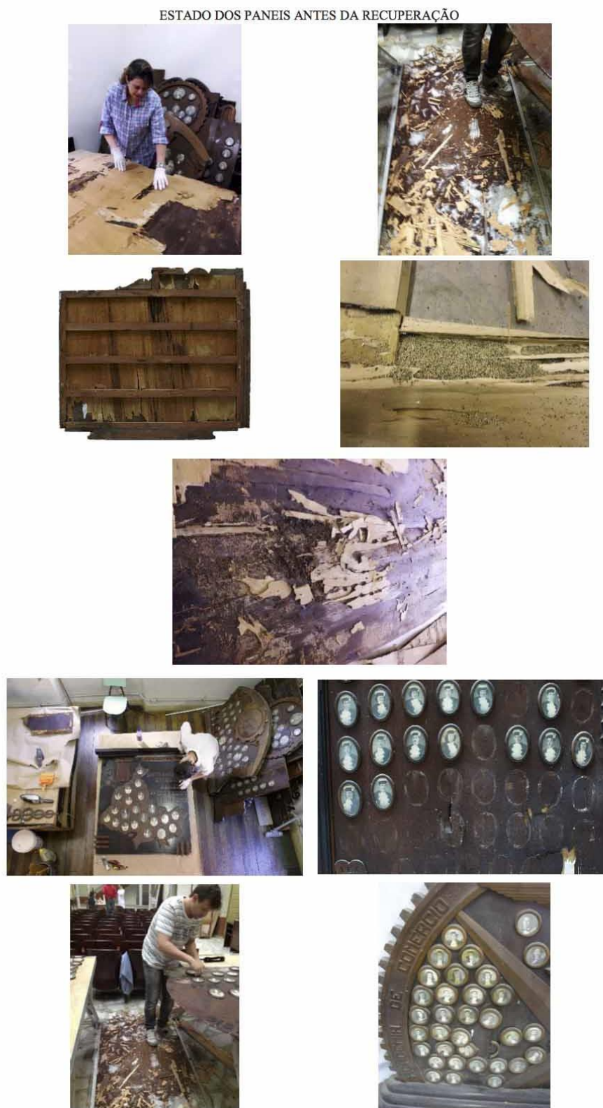
Figura 8 - Estado dos painéis antes da recuperação. No chão, madeira em pó, deteriorada por cupins.
