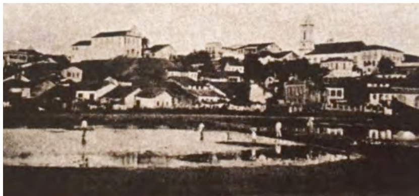
Figura 6 – Foto da região alagada do Campinho
